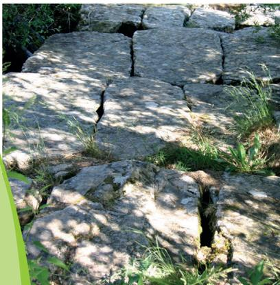
Ces très anciens ponts rustiques sont composés d'énormes dalles soutenues par des murets en pierres sèches sur les deux rives et par un ou deux piliers dans le lit du cours d'eau ; de grosses pierres sont disposées côté amont pour protéger les piles de la force de l'eau.
